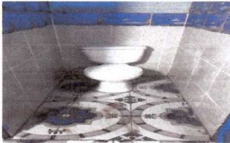
Foto1: Sustitución de inodoro
