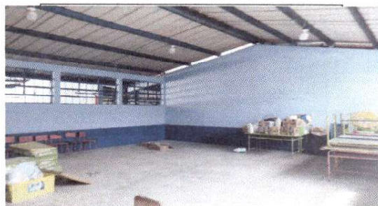
Foto 10: Pintura en muros interiores.
