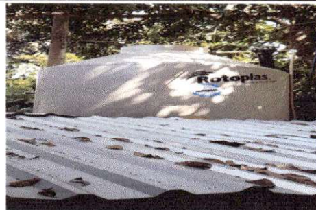
Foto 8: Sustitución de lámina, por lámina troquelada aluzin calibre 26
