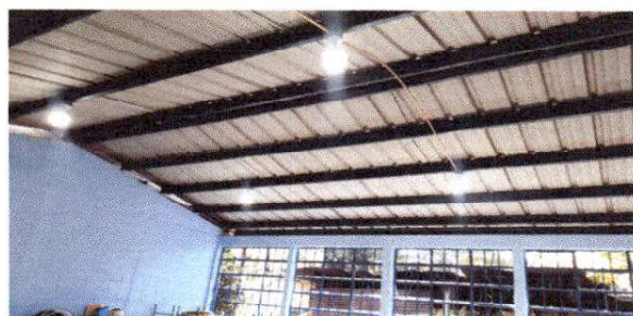
Foto 12: Sustitución de lámparas tipo LED, reparación de cableado eléctrico.
