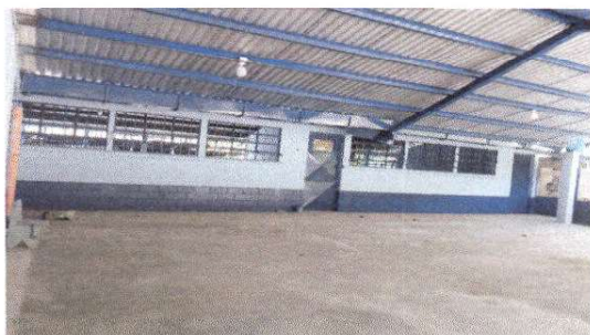
Foto 9: Pintura en muros exteriores
