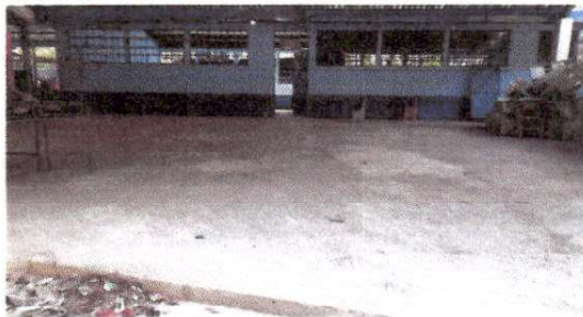
Foto 3: Reparación de piso torta.
