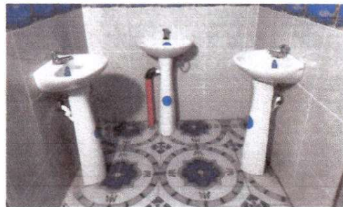
Foto 2: Sustitución de lavamanos.
