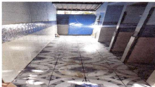
Foto 7: Sustitución de azulejo.
