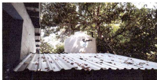
Foto 11: Sustitución de depósito de agua 2,500 lts
