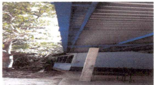
Foto 4: Sustitución de canal PVC
